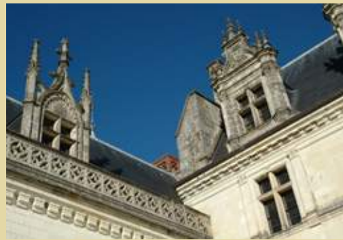
左から右へ:ゴシック様式の屋根窓(シャルル8世の棟)とルネッサンス様式の屋根窓(ルネッサンス様式、フランソワ1世の棟)
